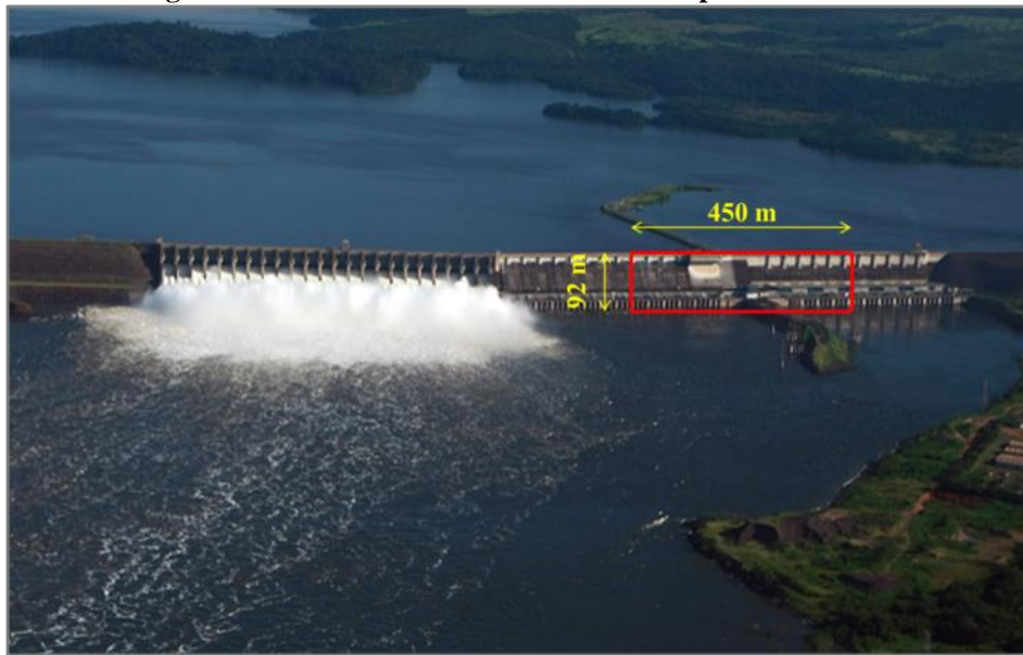
Fotografia 4 – Dimensões finais da brecha de ruptura considerada.
