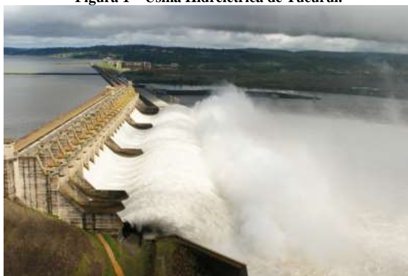
Figura 1 – Usina Hidrelétrica de Tucuruí.
